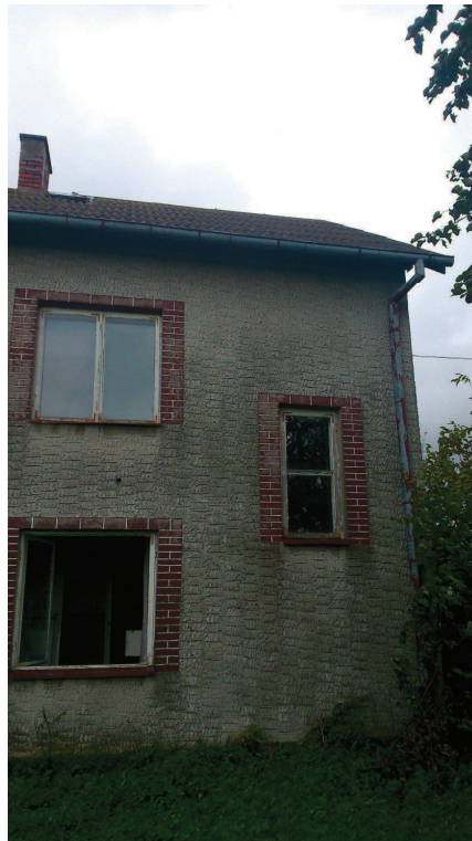
Fot. 5 – Elewacja północno-zachodnia.
