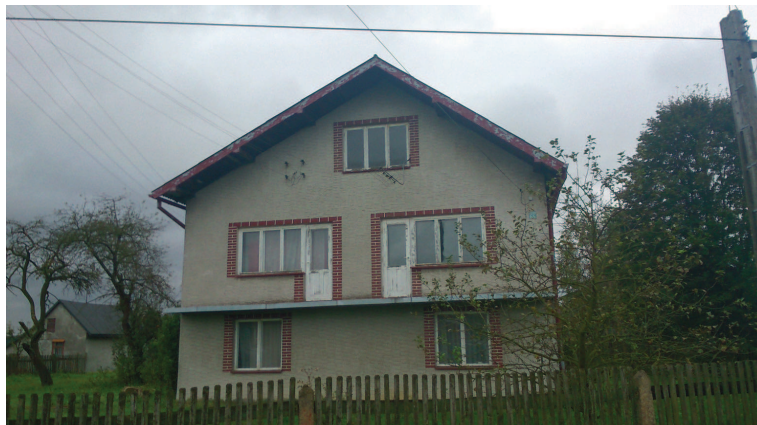
Fot. 1 – Elewacja frontowa – północno-wschodnia.
