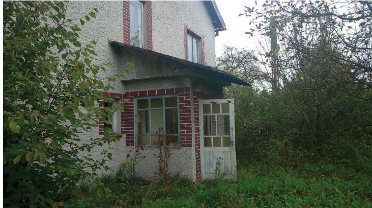
Fot. 4 – Elewacja południowo-zachodnia – wiatrolap do rozbiórki.
