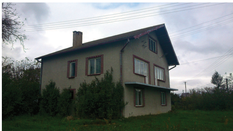
Fot. 2 – Elewacja południowo-wschodnia.
